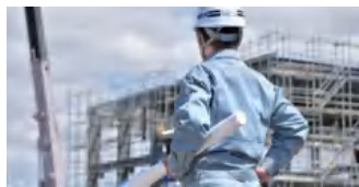
建設・工事現場
